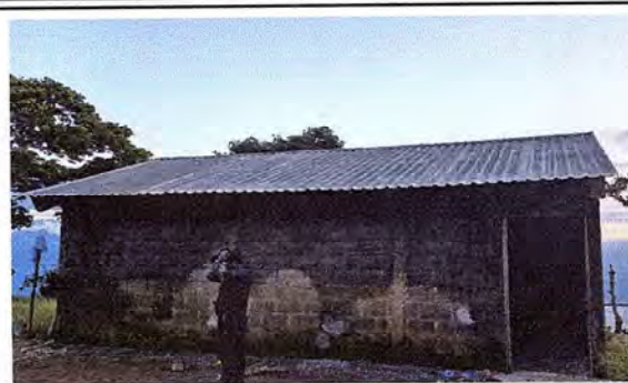
Foto 2: Techo de cocina cambiado, agujeros en las pared rellandos.
