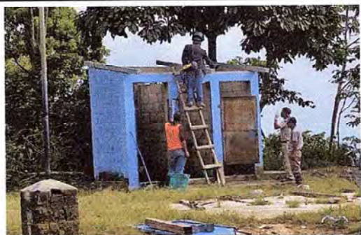
Foto 3: Cambio de techo y puertas deterioradas de losbaños, rellnados los agujeros en las paredes que dividen.
