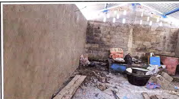
Foto 4: Se observa la aplicación de repello a las paredes interiores de la cocina.
